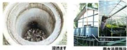
雨水貯留浸透施設の例
