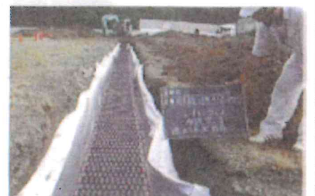
浸透トレンチ（溝）
