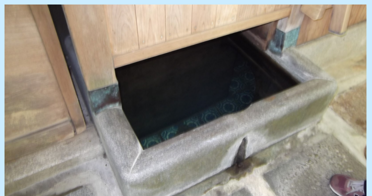
横井戸からの飲料水を貯める台所の床下に設けられた貯水槽
