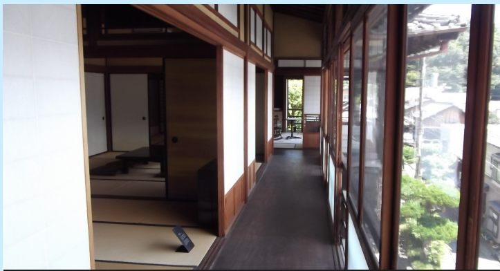
「太平洋鉄木」で仕上げられた廊下
